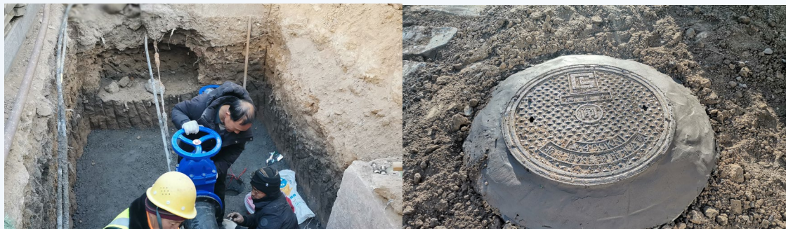
亚运村（北辰集团园区）再生水引入项目
